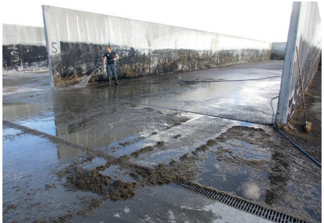
Bild 3 Silokammern gelten als sauber, wenn sie besenrein und anschließend nassgereinigt werden (Quelle: LAZBW H. Nußbaum).
