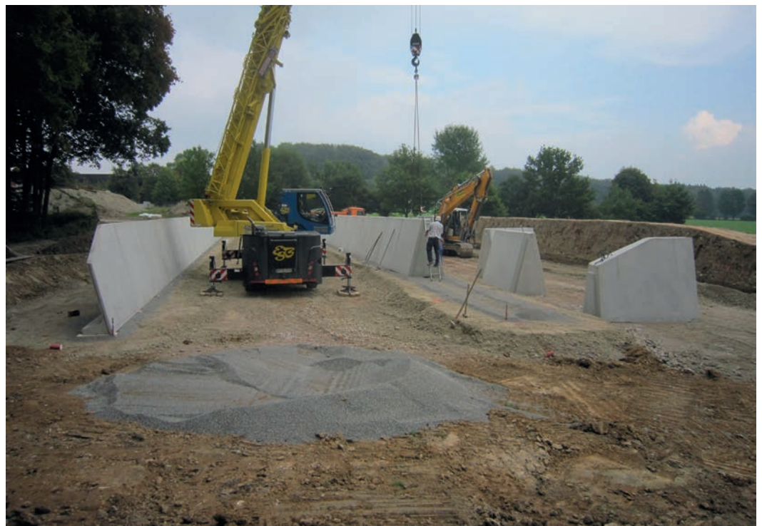
Bild 1 Siloanlagen ab 1000 m 3 Lagervolumen dürfen nur durch Fachbetriebe errichtet werden.. Vor Inbetriebnahme muss die Abnahme durch einen externen Sachverständigen erfolgen. (Quelle: LAZBW, Dr. H. Nußbaum)
